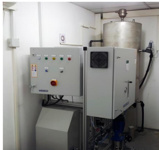
Figura 3 – Ozonizzatore dell'impianto di trattamento del centro di ricerca Shafdan.
