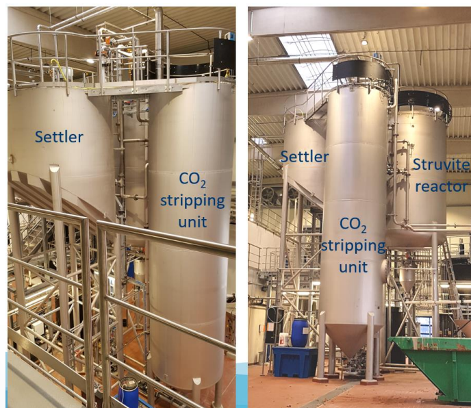
Figuur 3: Struviet productie montage
