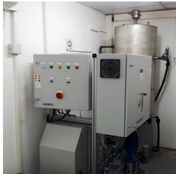
Abbildung 3 - Ozonator der Shafdan KA im F&E-Zentrum
