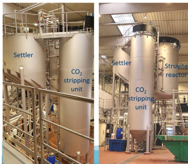
Figura 3: Montagem da produção de estruvite
